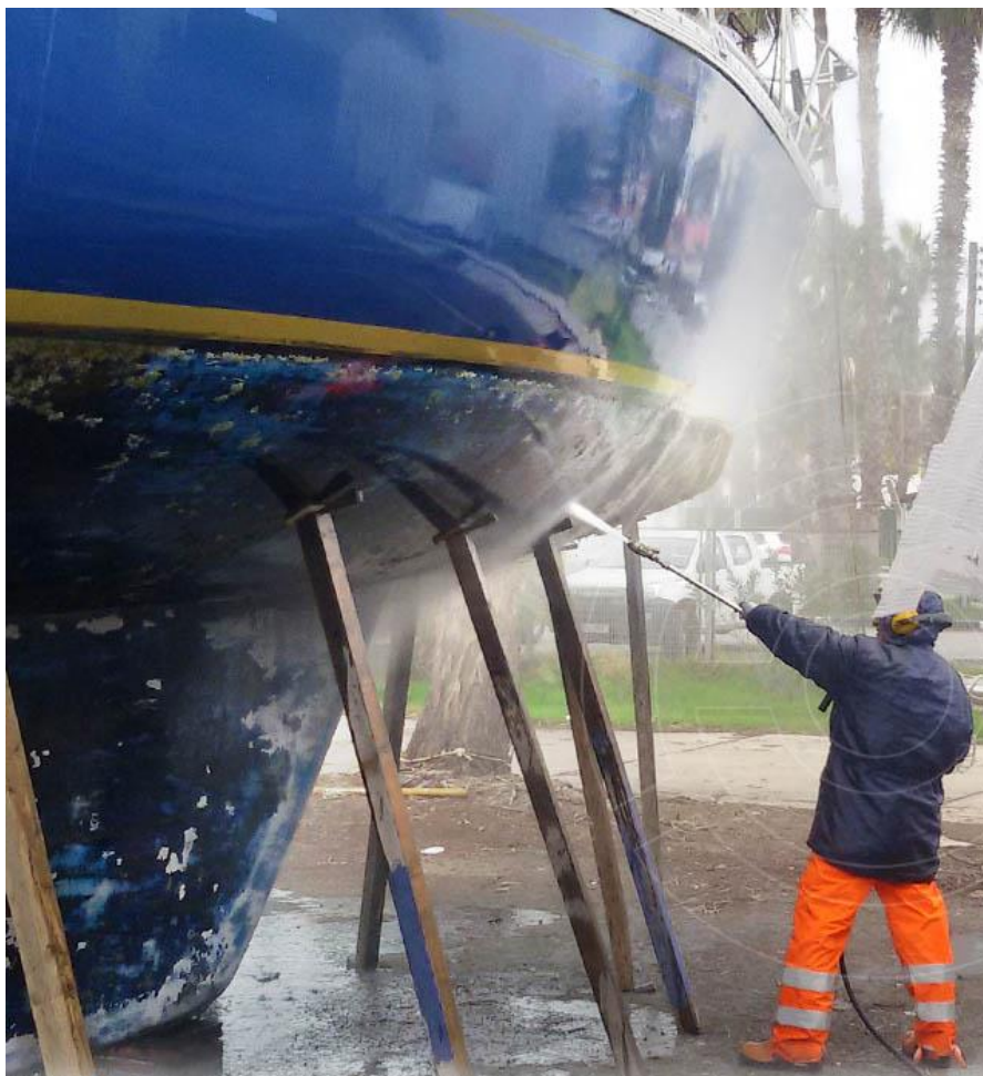
شکل ۳-۲۴ غبارپاشی با فشار زیاد برای پاک‌سازی بدنه شناور (عکس از: post-industrial.com ).
